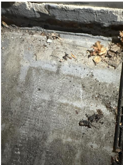
Powłoka malowana posadzka na balkonie m.16
