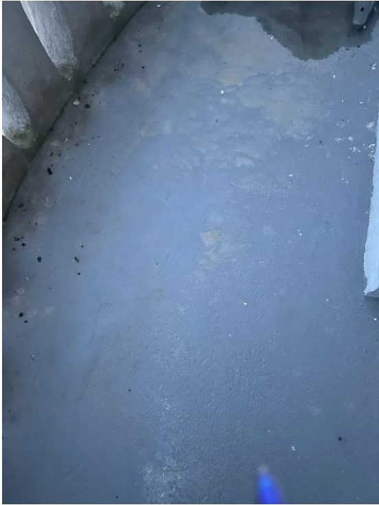
malowanie na balkonie m.9
