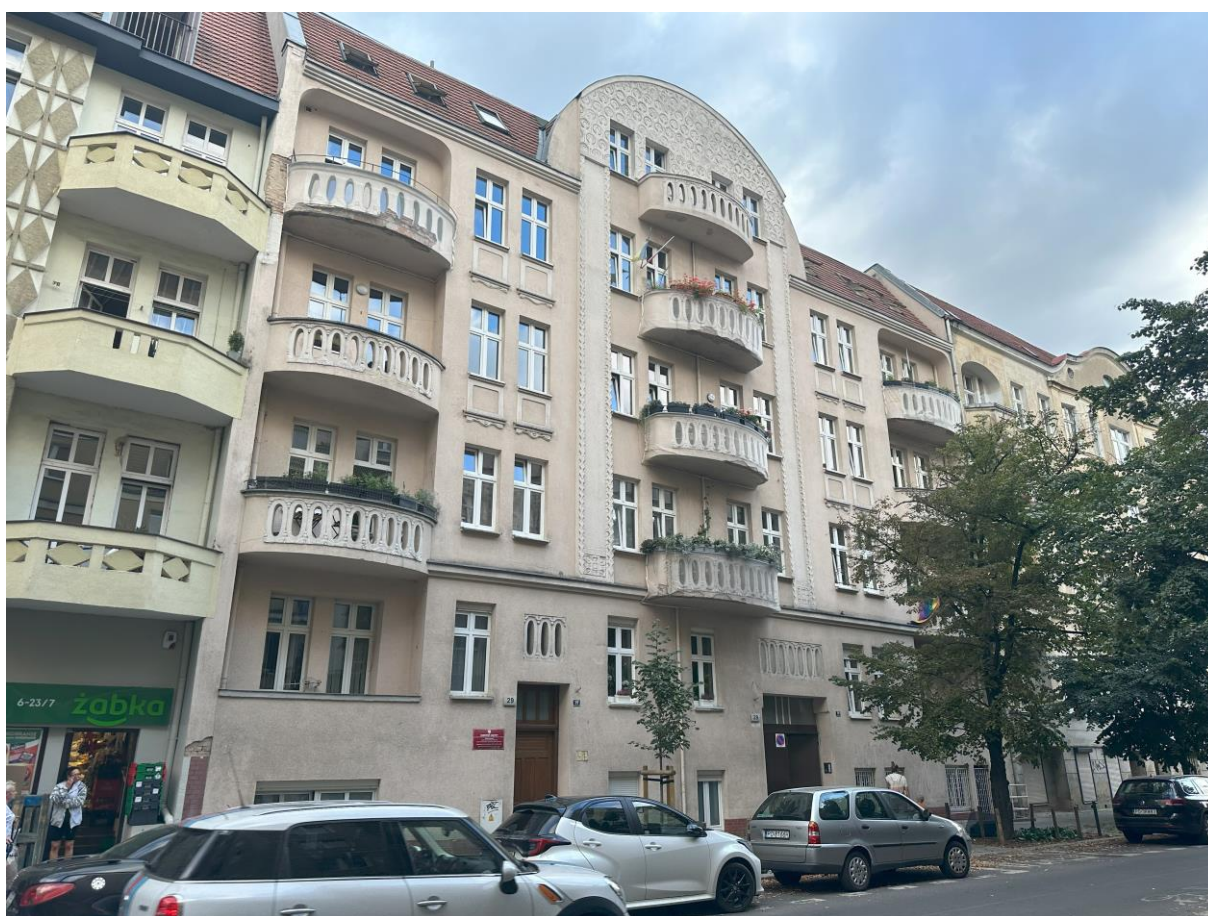
Widok na elewację frontową
